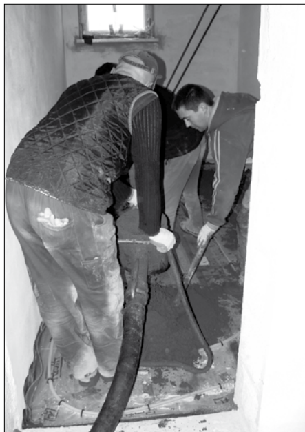
Podczas wykonywania wylewek
