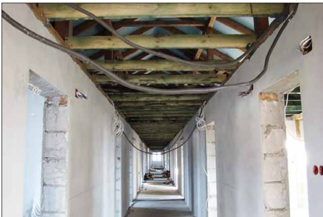
Konstrukcja sufitów na poddaszu
