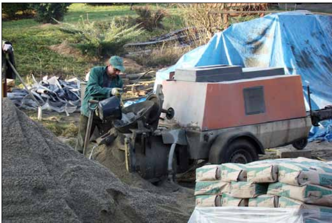
Prace przy wykonaniu wylewek
