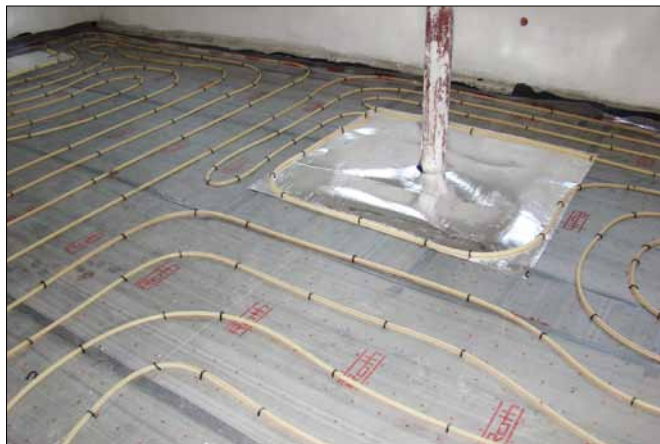
Podłogowa instalacja grzewcza
