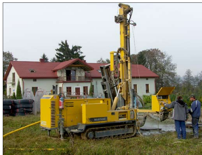
Wiercenie otworów pod pionowy kolektor dla pompy ciepła
