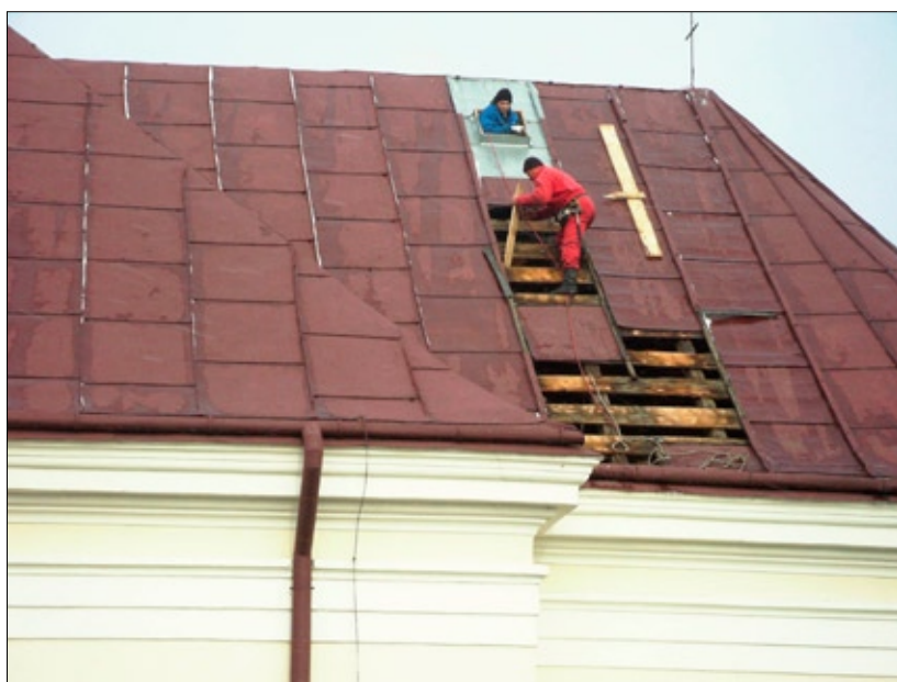
Naprawa poszycia dachu po wichurze
