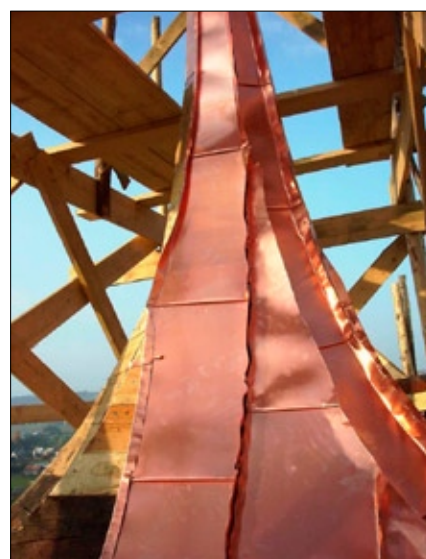
Prace remontowe na wieży kościoła
