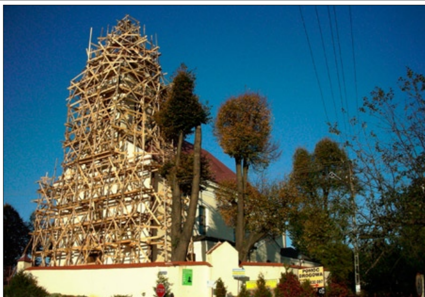
Wygląd kościoła w czasie prac remontowych
