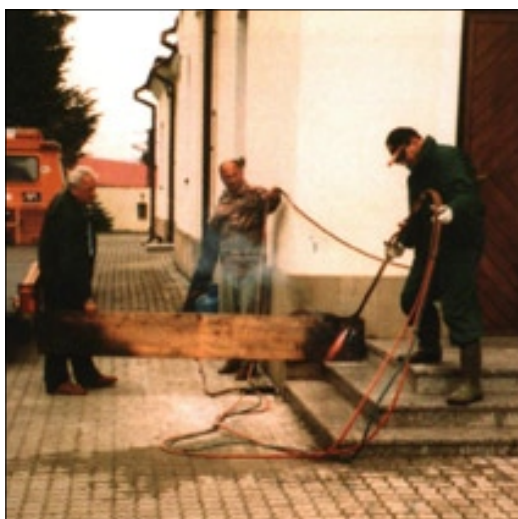
Prace przy schodach kościoła
